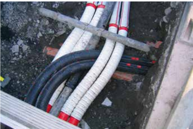
Längverschluss- und Systaflex-Bogen Fermeture longitudinale et coudes Systaflex Curve a chiusura longitudinale e Systaflex
