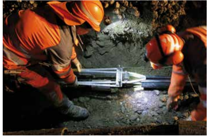
Ansetzen des Einzugschlittens Installation du tire-fil Impostazione della slitta di trazione
