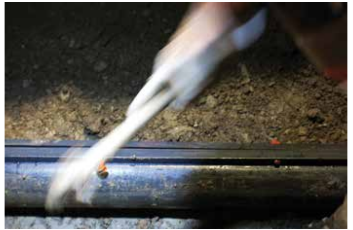
Einklopfen der Verschlussbolzen (Endverschluss) Enfonçage des chevilles de fixation (extrémité) Battuta del bullone di chiusura (chiusura finale)
